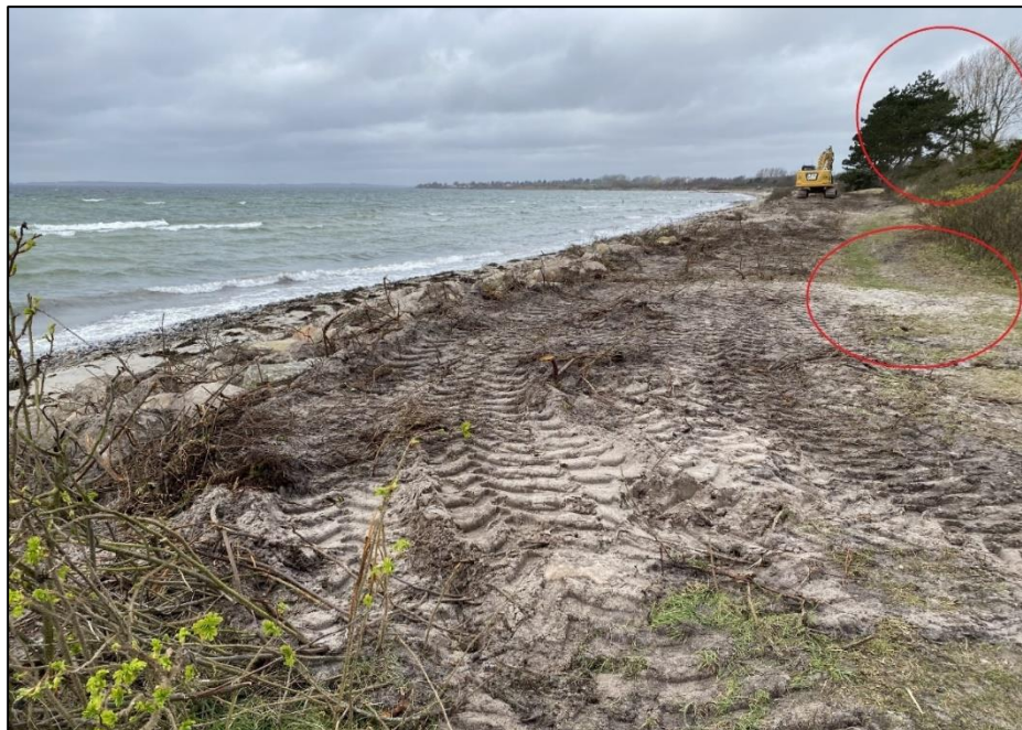
Figur 9. Foto taget ved besigtigelse den 30. marts 2023. De røde cirkler markerer en tidligere adgang ud mellem buskene til stranden, som ses af sand på stien, samt en klynge træer. Både sandet fra sstien ned til stranden og træerne kan genses på figur 8. Ud fra de to billeder ses ændringen af diget fra bevokset med hybenbuske til ryddet for planter og anlagte sten.
