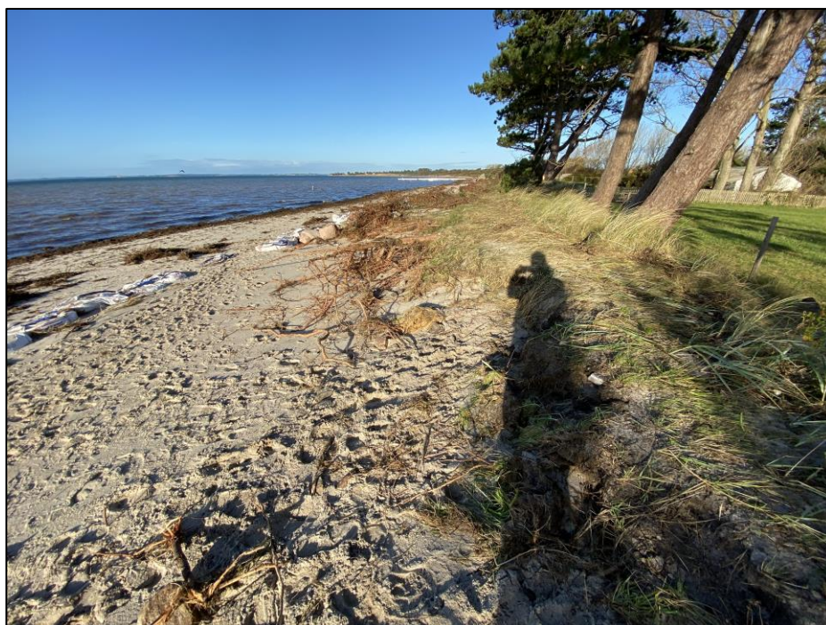
Figur 12. Foto taget ved besigtigelse den 23. oktober 2023 efter stormfloden den 20.-21. oktober 2023. Fotoet viser strækning C tæt ved strækning B. Af strækningen ses, at der ikke har været større sten langs diget. Der er kun enkelte sten spredt langs diget.
