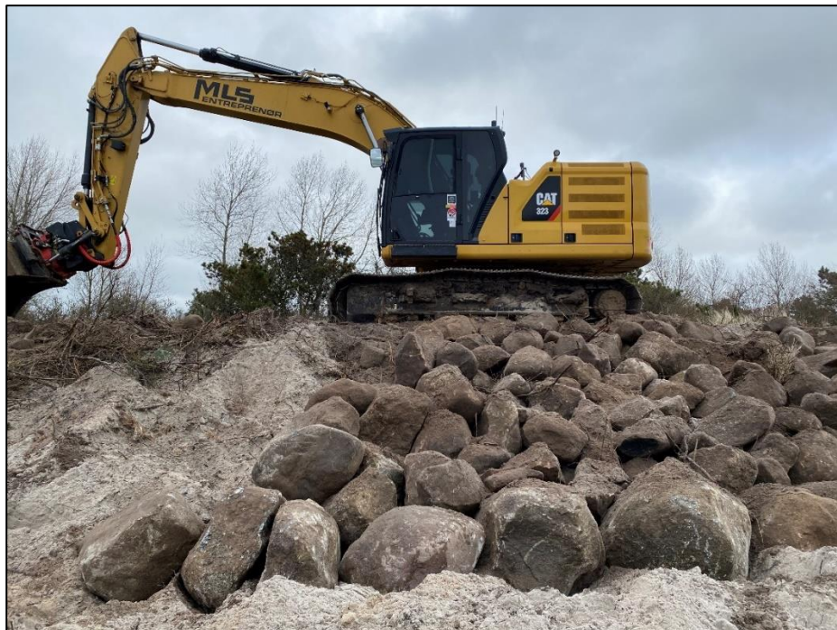
Figur 11. Foto taget ved besigtigelse den 30. marts 2023. Den nordvestligste ende, hvortil der er anlagt stenskråning på stranden og den havvendte side af diget, ca. 105 m fra, hvor stenskråningen begynder (figur 10). Rendegraveren, som er anvendt til anlægsarbejde. Til venstre for stenene på billedet, ses tegn på gravearbejde på et areal, som før var tilgroet i buske.
